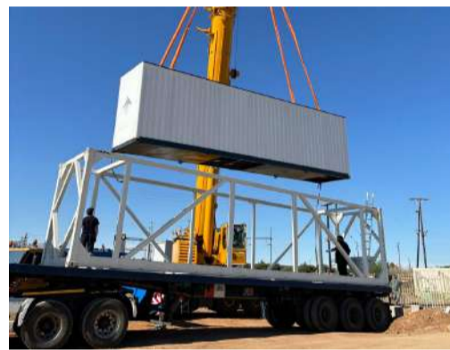
Die uitlig van die batterye vanuit 'n metaal raamwerk wat dit moes beskerm begin
